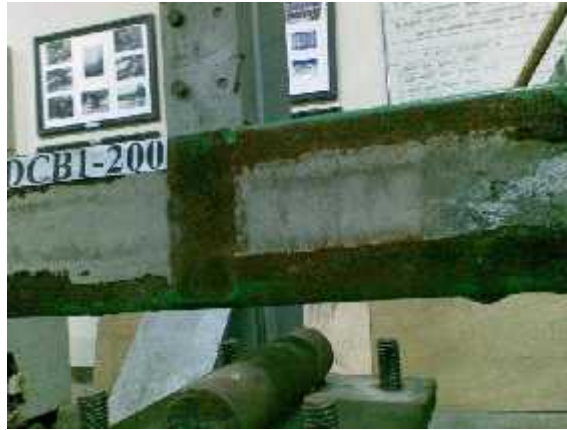
Gambar 2. Kegagalan kolom pendek dengan pengisi beton ringan
