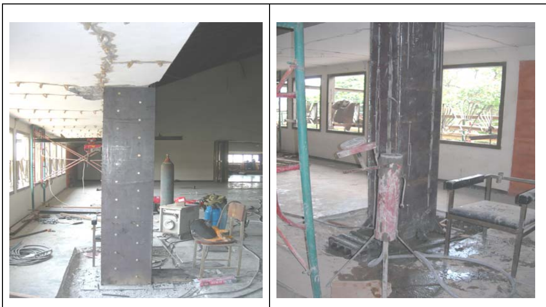
Gambar 9. Pembungkusan kolom dengan pelat baja dan grouting kolom
