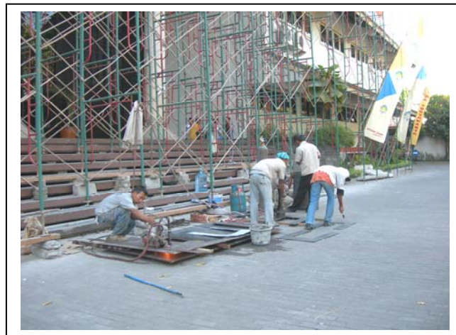
Gambar 13. gedung yang disangga dengan scaffolding
