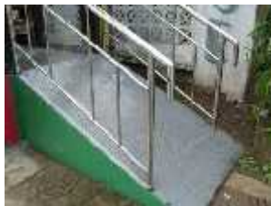
(1.a) kondisi ramp halte bus yang terlalu curam
