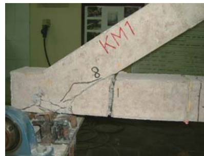
Gambar 6. Tampak depan retak ke 1 yang menyebabkan keruntuhan
