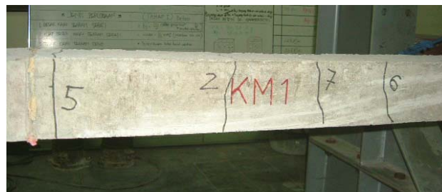
Gambar 7. Retak pada batang horizontal sebelah kiri
