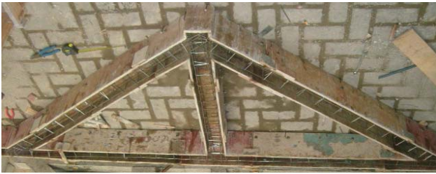
Gambar 3. Tulangan rangka batang di dalam cetakan monolit
