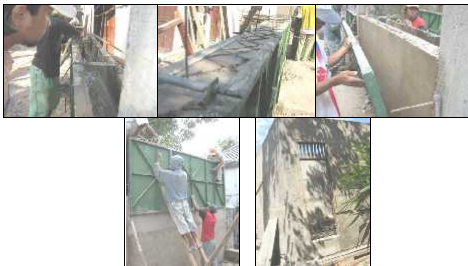
Gambar 6. Proses pembuatan dinding dengan metode cor di tempat , Sumber : Satyarno, I., 2008
