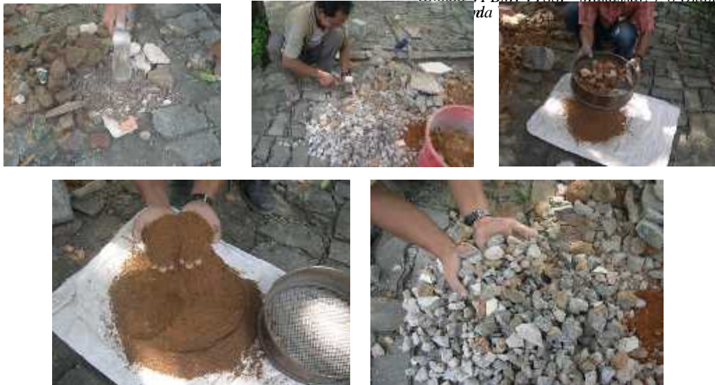
Gambar 5. Proses Daur Ulang Pecahan dinding menjadi pasir dan kerikil, Sumber : Satyarno, I., 2008
