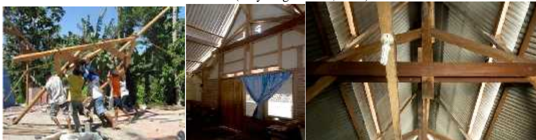
Gambar 2. Proses rekonstruksi desa Ngibikan, penggunaan material sisa dan kayu kelapa sebagai struktur atap (sumber : Brigitte Shim, 2010)
