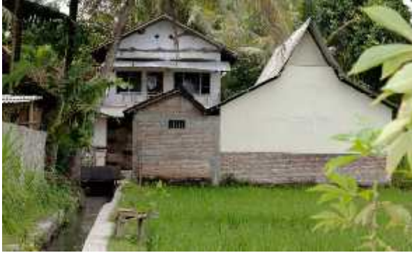
Gambar 3. Dinding bata yang dikombinasikan dengan panel dinding fibercement, Sketsa desain rekonstruksi rumah desa Ngibikan oleh Eko Prawoto Sumber : Brigitte Shim, 2010
