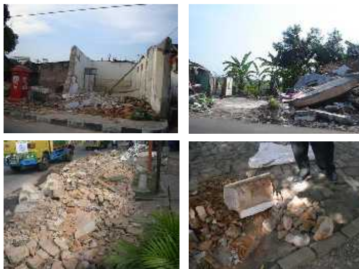
Gambar 4. Limbah reruntuhan tembok yang dianggap tidak bisa digunakan kembali, Sumber : Satyarno, I., 2008
