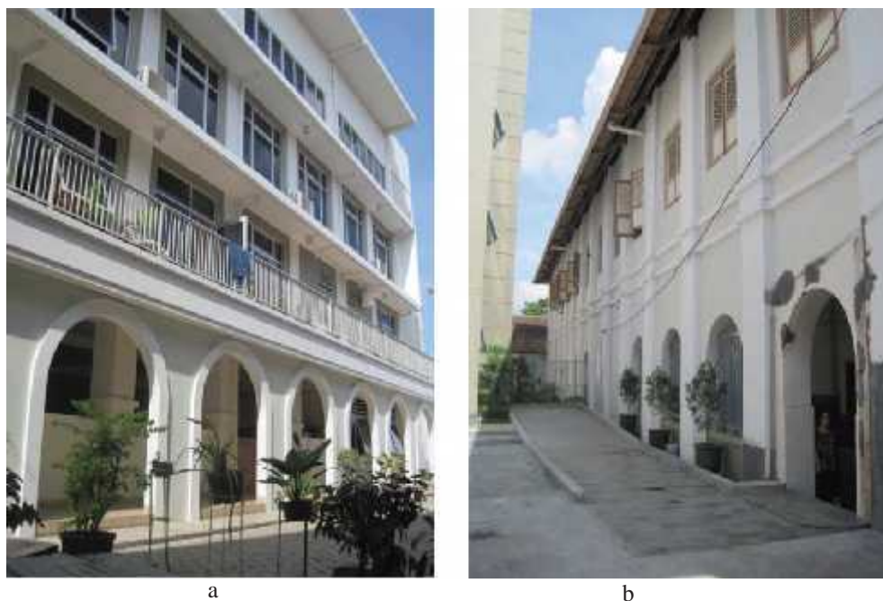
Gambar 17. Unsur pengikat berupa bentuk semicircular arch yang digunakan pada koridor yang terletak di lantai dasar Gedung Pusat Pastoral Keuskupan Bogor (a) dan Gedung Seminari Stella Maris Bogor (b). Sumber: Dokumen Penulis, 2013
