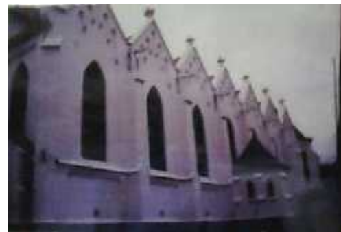
Gambar 5. Bentuk flying buttress sebagai aksesoris di antara deretan jendela kaca patri berbentuk pointed arch
