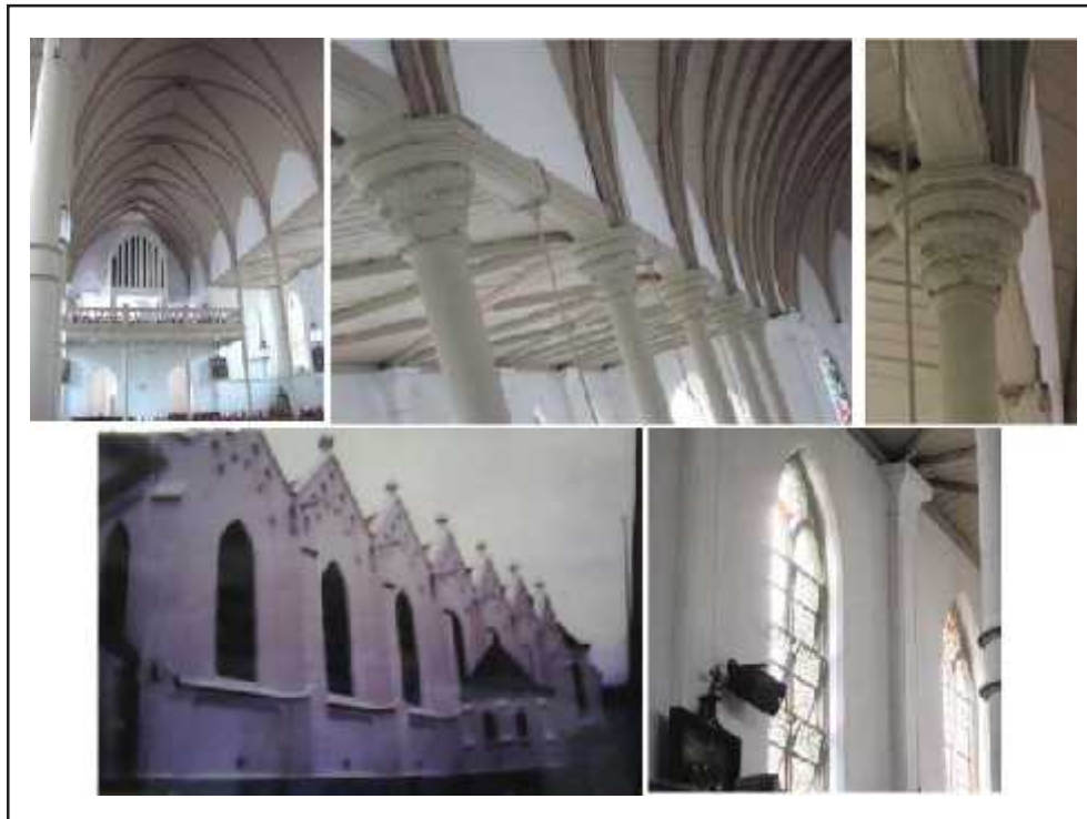
Gambar 11. Unsur-unsur struktural pada bangunan Gereja Katedral Keuskupan Bogor Sumber: Dokumen Penulis, 2013
