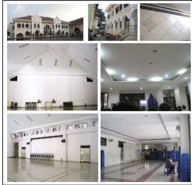
Gambar 12. Langit-langit ( ceiling ) dan lantai pada Gedung Paroki Katedral Bogor Sumber: Dokumen Penulis, 2013
