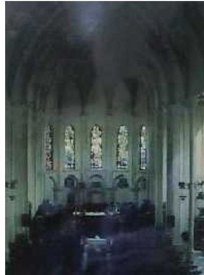
Gambar 4. Sistem vaulting pada langit-langit bangunan
