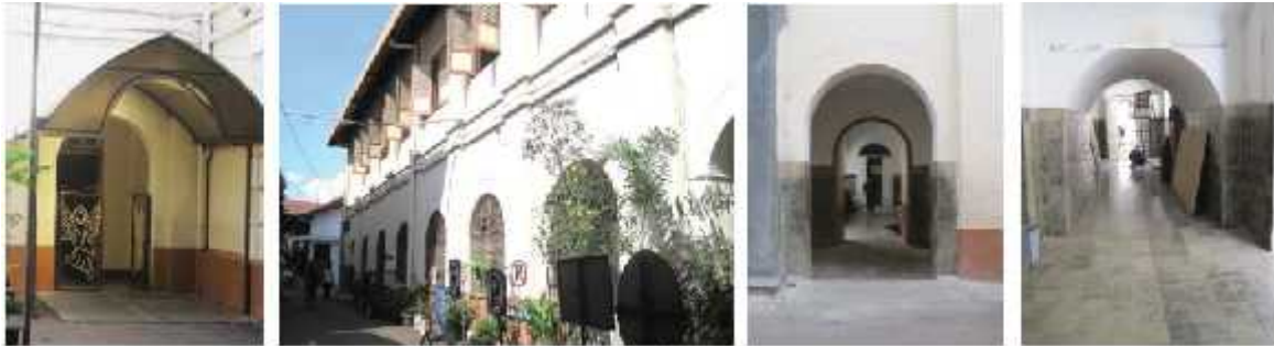
Gambar 15. Bentuk semicircular arch pada pintu masuk utama, jendela, dan koridor di Gedung Seminari Menengah Stella Maris Bogor Sumber: Herliana, 2013:II.168
