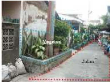
Gambar 5. Kondisi Jalan Lurung Penggal 2 Sumber : Analisis, 2014
