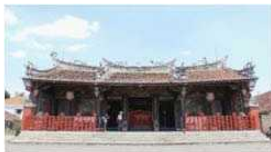
Gambar 4. Klenteng See Hok Kiong sebagai public monuments
