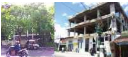
Gambar 8. Contoh Bangunan Melebihi 3 Lantai Sumber: Peneliti, Maret 2013
