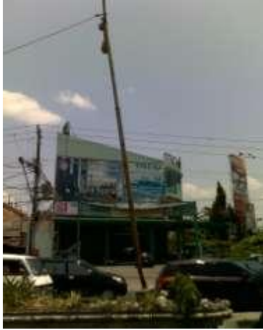
Gambar 1. Tiang utilitas ditabrak
