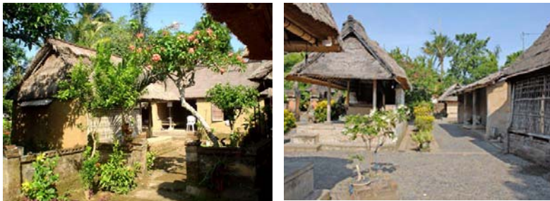
Gambar 3. Kondisi Rumah Nyoman Mandra Sumber: Sahriyadi, 2011
