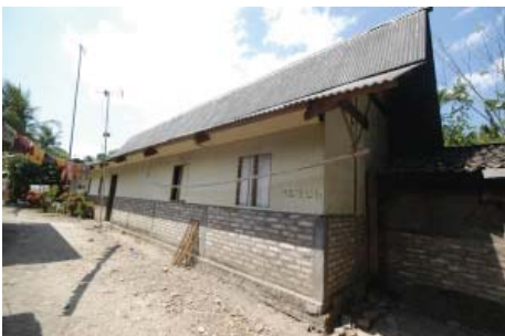
Foto 7. Rumah no. 49 dan 50 dengan konfigurasi modul struktur memanjang Sumber: Dokumen peneliti, 2011
