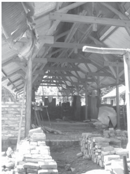
Foto 5. Konfigurasi Struktur Model Memanjang . Sumber: Dokumen peneliti, 2006
