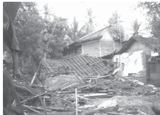
Foto1. Salah satu bangunan yang roboh di Dusun Ngibikan
